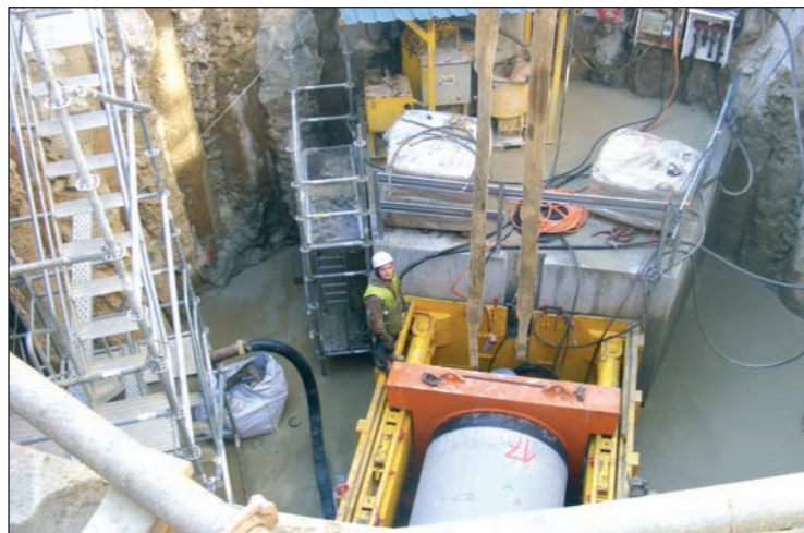
■ Vista de uno de los pozos de ataque.
