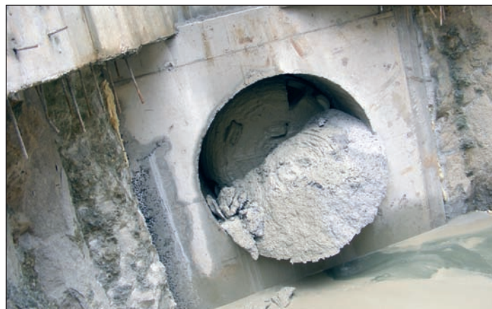
■ Salida al PR 19, después de 403,2 m de hinca.
