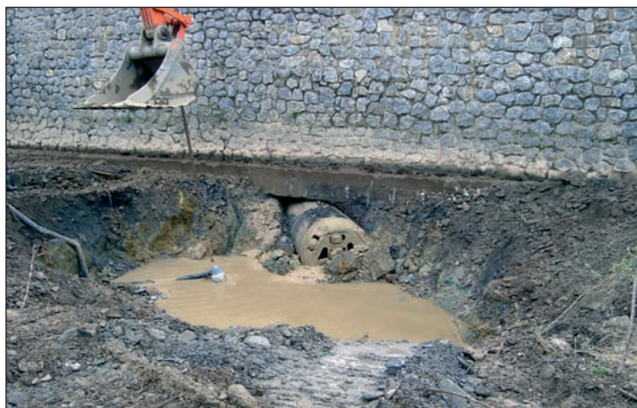
Salida de microtuneladora desde el pozo PR 21 al río.
