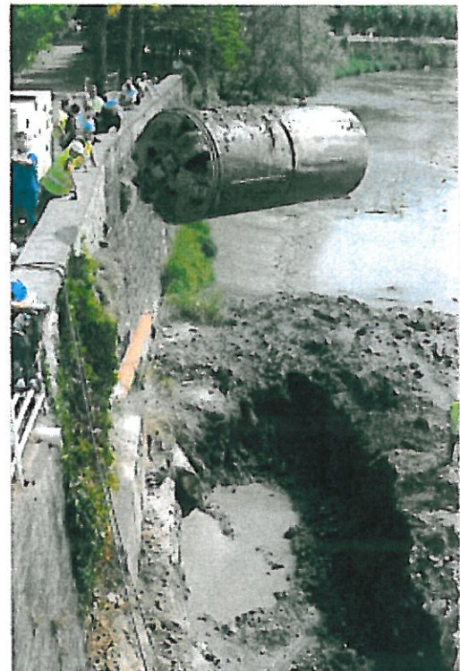
Momento en que la microtuneladora es retirada tras ir a desembocar al río Oria.
